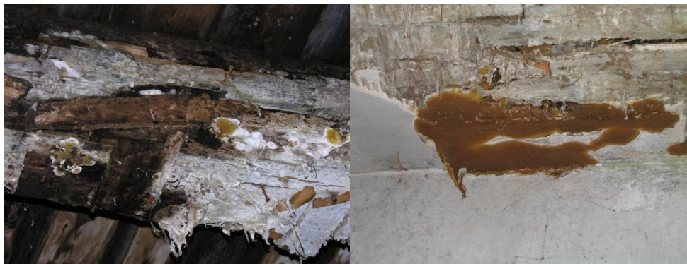
12. att. Serpula lacrymans micēlijs un auklas senu dzirnavu griestu sijā; sēnes augļķermeņi uz griestu apmetuma un dēļiem.
