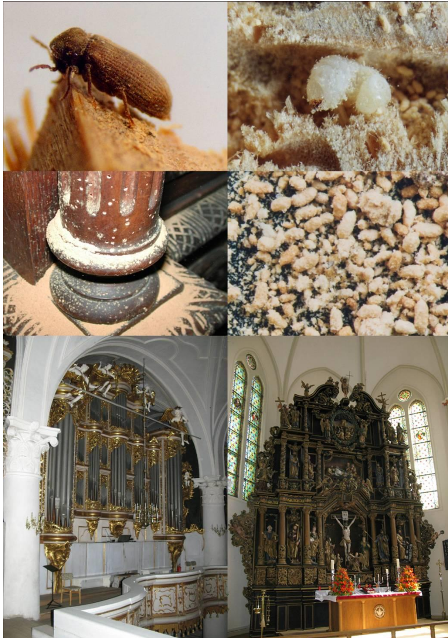
8.att. Mēbeļu ķermis: Vaboles māfīte; kāpurs. – Raksturīgi masīvi koksnes bojājumi; koksnes milti ar ekskrementu daļiņām, kam vienpusēji spīci gali. – Liepāja: Sv. Trīsvienības baznīca, koksnes kaitēkļu bojājumi ērgelēs; Sv. Annas baznīca, kukaiņu bojājumi altārī.
