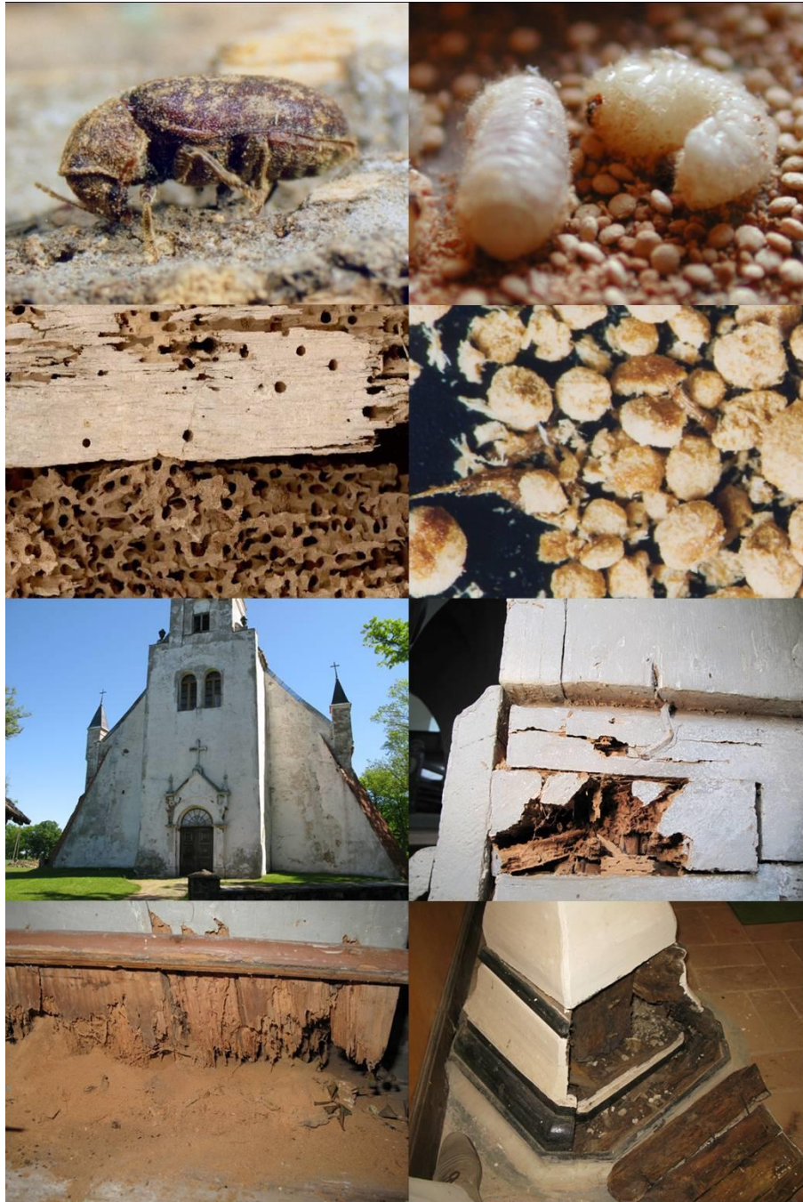
11.att. „Nāves pulkstenis“: Vaboles māfīte; kāpurs. – Raksturīgi masīvi koksnes bojājumi; koksnes milti ar lēcveidīgām ekskrementu daļiņām. – Burtnieku lūt. baznīca; Bojājumi kolonnas pamatnē; -Turlavas Lipaiņu baznīca: Bojājumi kanceles balstā.
