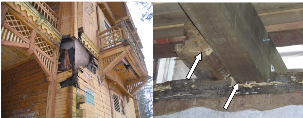
9. att. Slikti uzturēta kultūrvēsturiska dzīvojamā ēka; celtniecības kļūda atjaunotās dzirnavās – no satrupējušās mūrlatas (bulta) un vecās sijas gala (bulta) trupes sēne Coniophora puteana ir inficējusi jauno siju.
