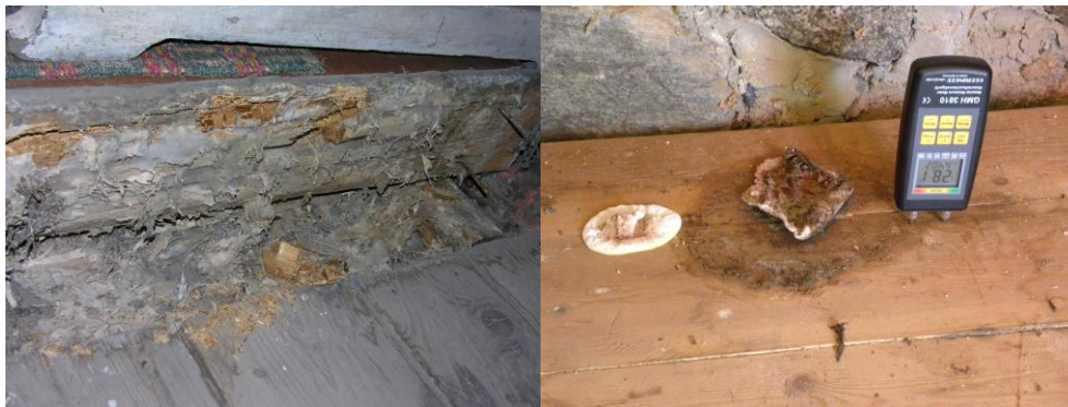
4. att. Plaši īstās mājassēnes bojājumi zem baznīcas vecās grīdas; muzeja ratnīcas restaurētā grīda satrupējusi - īstās mājassēnes bojājumi, koksnes mitrums 28%.
