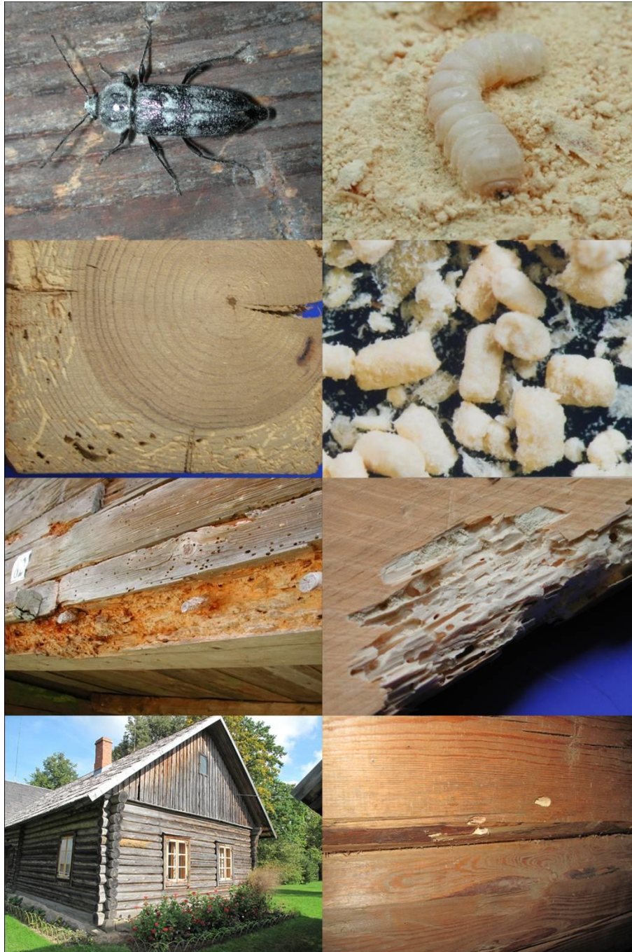
6.att. Ēku koksngrauzis: Vaboles māfīte; kāpurs.– Grauzuma šķērsriezums aplievas daļā; cilindriskā veida ekskrementu daļiņas. – Masīvi bojājumi ēkas ārpusē; bojāts grīdas dēlis. – Kolnasāta: Zemnieku sētas daļa; izskrejas caurumi ēkas iekšpusē.
