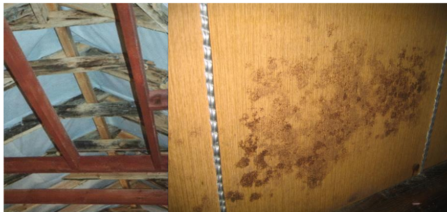
18. att. Pelējuma sēnes uz atjaunotas dzīvojamās ēkas jumta dēļiem; pelējums uz baznīcas iekšējās sienas saplākšņa apšuvuma.
