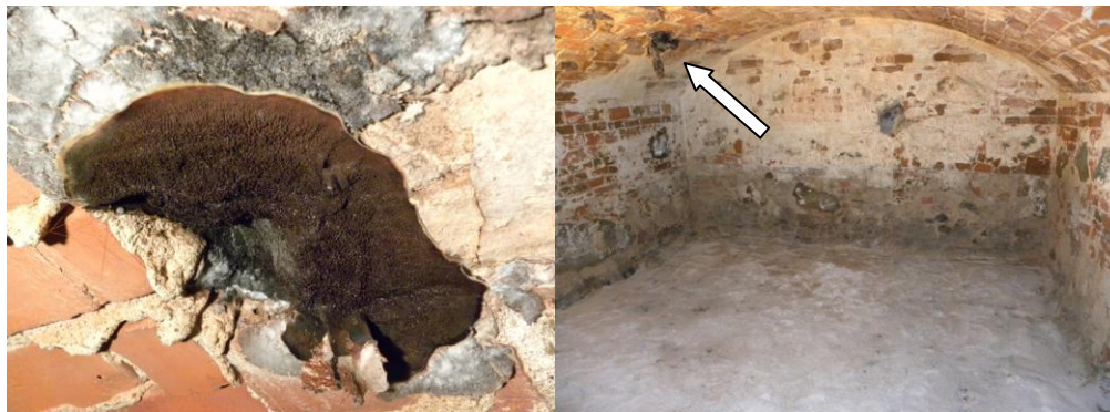
5. att. Īstā mājassēne mitrā baznīcas pagrabā uz mūra griestiem (bulta).
