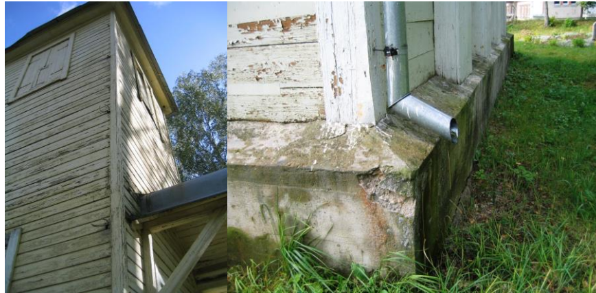
3. att. Mitras sienas un pamati baznīcā, nav uzstādītas ūdens notekas; nepareizi uzstādīta ūdens noteka, kas mitrina baznīcas pamatus.
