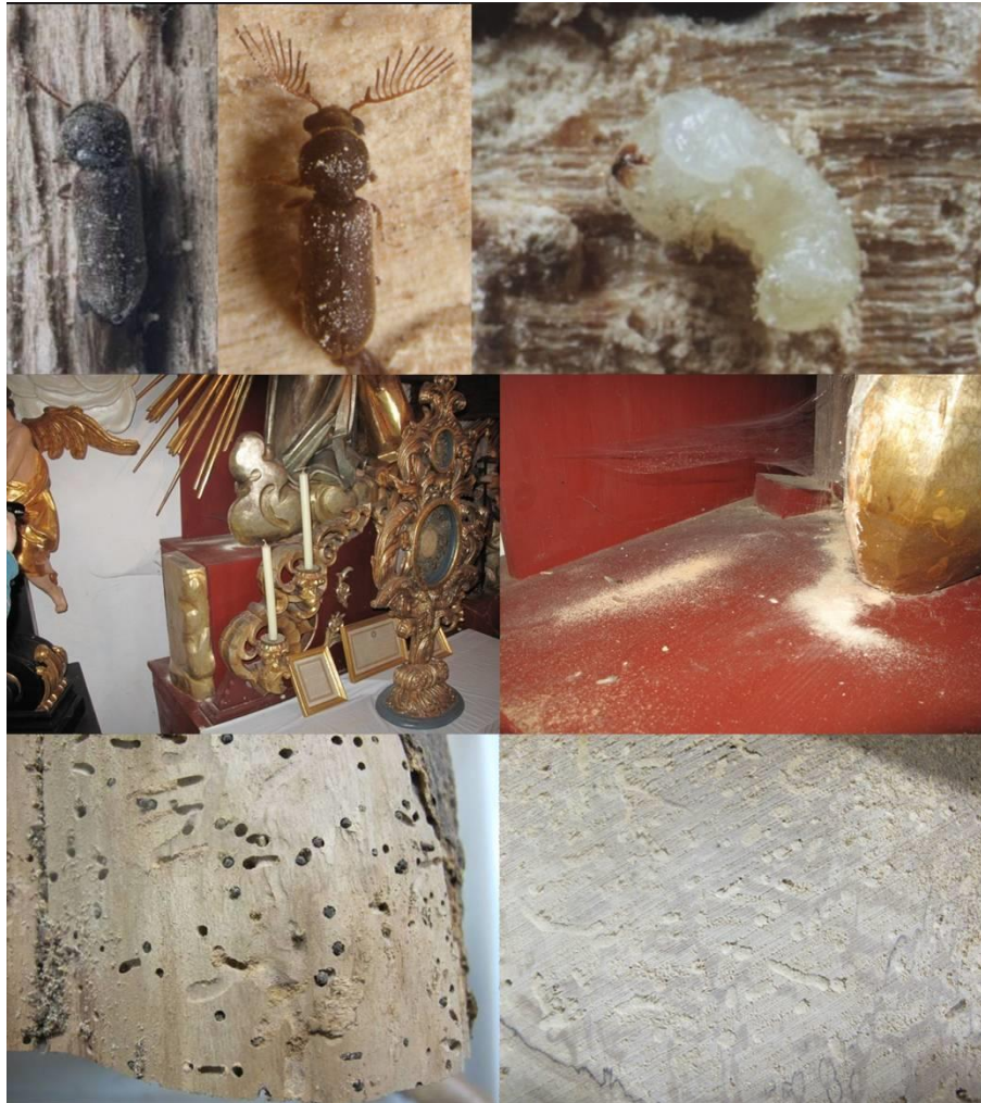
13. att. Ķīrmis: Māfīte un tēviņš; kāpurs. – Raksturīgi bojājumi baznīcu interjerā; masīvi bojājumi ar smalkiem koknes miltiem (detalizēti). – Beigtas vaboles ejās zem koknes virsmas; izgrautās ejas dažādos virzienos.
