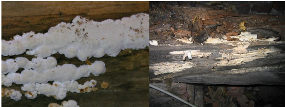
14. att. Antrodia sinuosa jauni augļķermeņi muižas griestu dēlī; veci augļķermeņi baznīcas jumta konstrukcijā.
